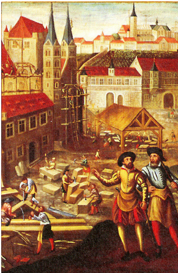
Bauarbeiten am Dom: im Vordergrund wird der Dachstuhl zusammengesetzt, Steinmetze behauen die Quader, die mit Tretrad und Kran am Gerüst aufgezogen werden. Ein zweiter Kran mit einem Mörteleimer steht über dem Langhaus. Hinter dem Dom sieht man die „Hohe Warte“, den in der Barockzeit abgebrochenen Burgturm, daneben die „Neue Hofhaltung“. Im Hintergrund über den Weinbergen den Michelsberg, an dem ebenfalls gebaut wird. (Tafel aus der „Ottolgende“, Michelsberg 1617. Foto: Limmer)
